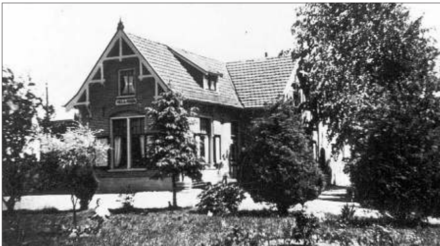
De koetsierswoning “Villa Marie” aan het Bruinhorsterpad.
